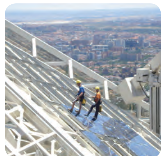
Cristal Tower MARTIFER SOLAR SA
