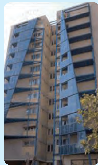
Обновяване на фасадата на многофамилна жилищна сграда с интегриране на фотоволтаици (Таврос, Атина) Източник: SOURSOS
