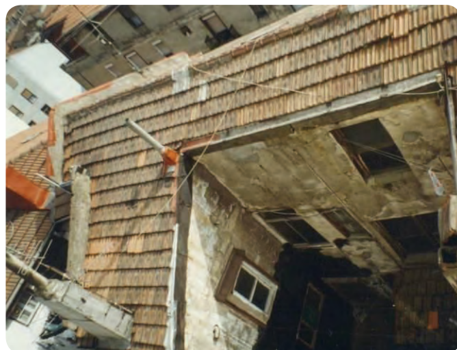
Покрив на обследваната сграда
